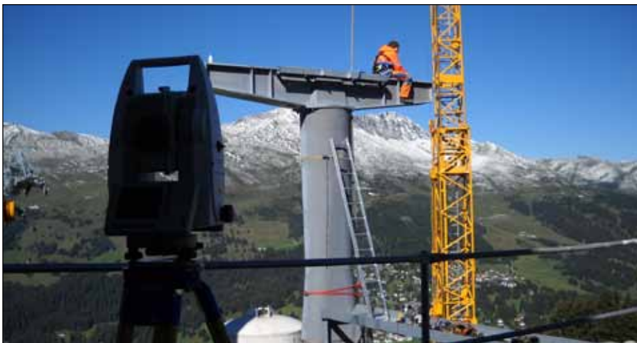
Gondelbahn Canols-Scharmoin: Vorderen Steher richten
