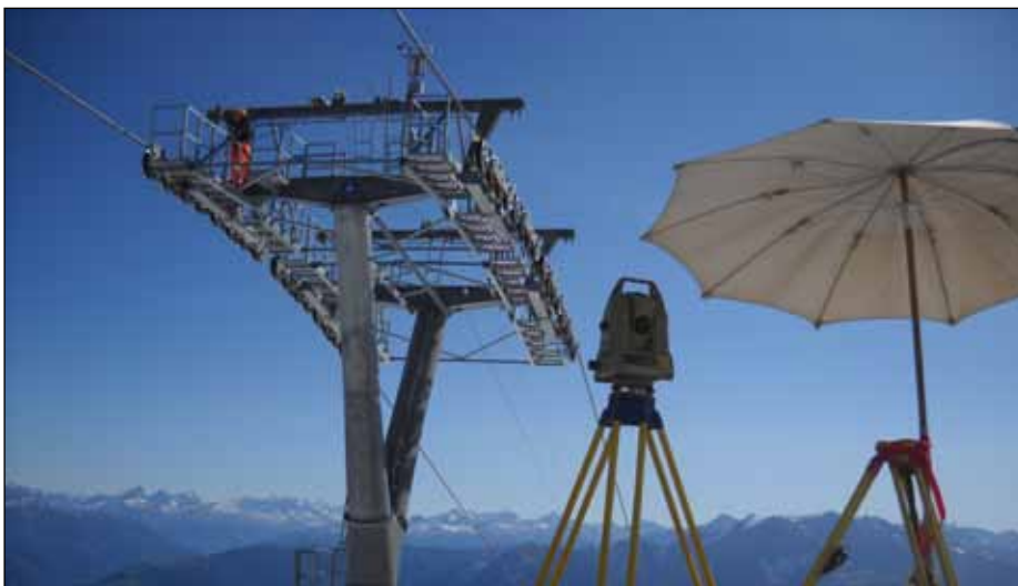
Kontroll-Messung zur Überprüfung der Stabilität der Stützen.
